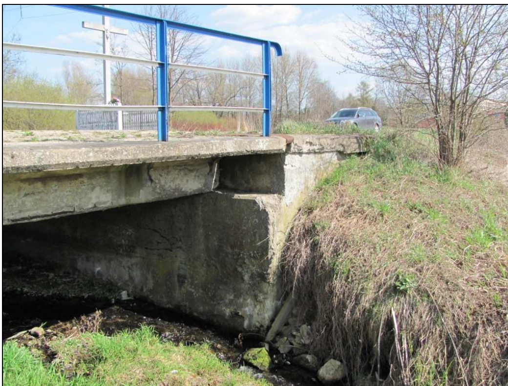
Zdj.10 Gzyms od strony dolnej wody - widoczne ubytki betonu na skrzydle.
