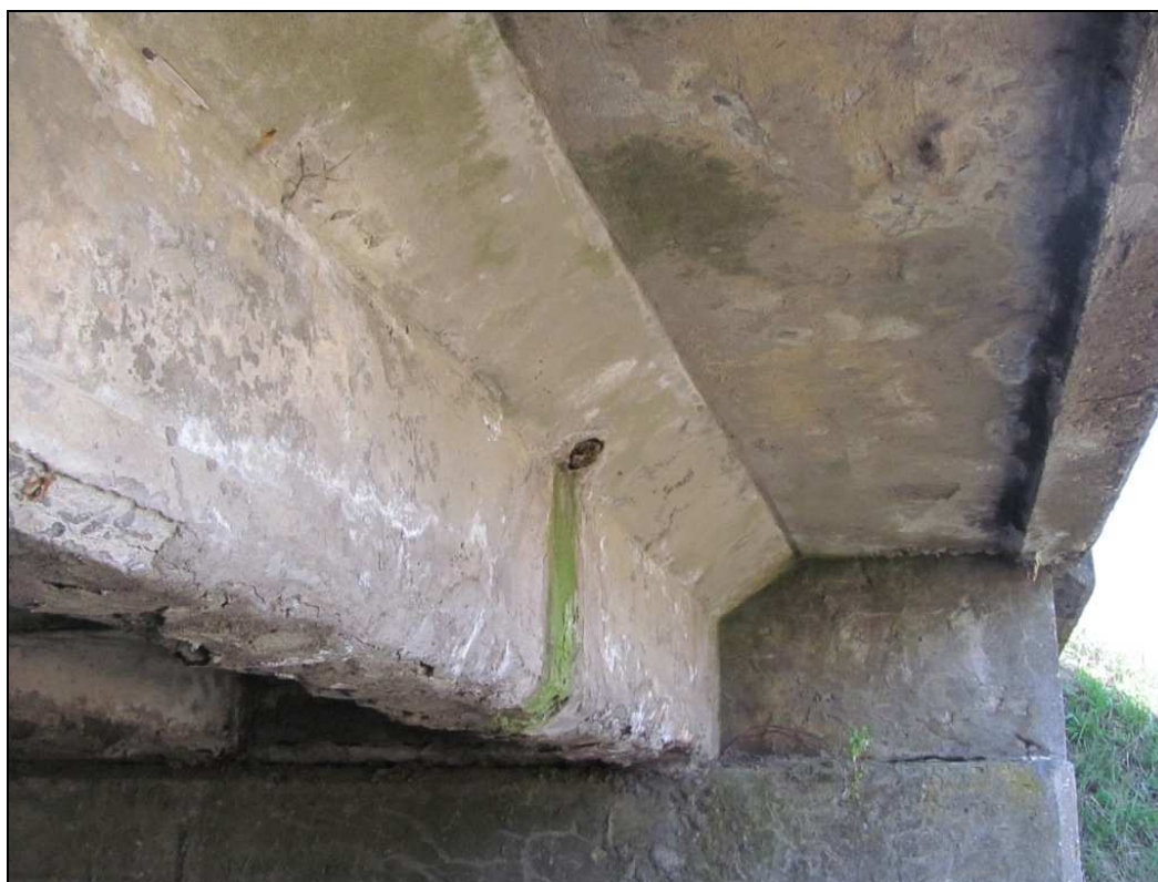
Zdj.12 Konstrukcja nośna (GW)- widoczne zawilgocenia, białe i zielone osady, spękania i ubytki betonu dźwigara.
