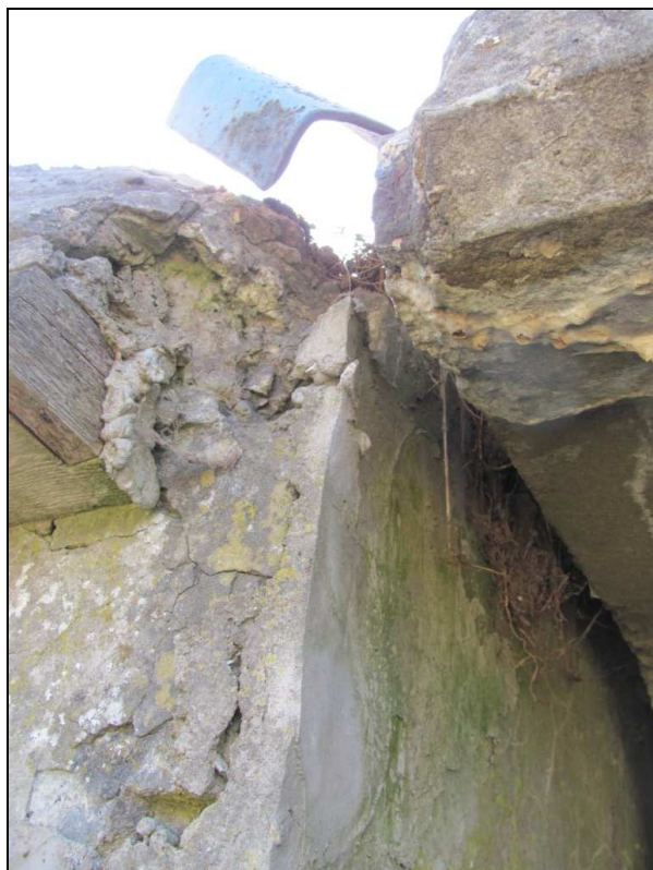
Zdj.20 Przyczółek - widoczne rozległe ubytki betonu gzymsu w strefie dylatacyjnej.
