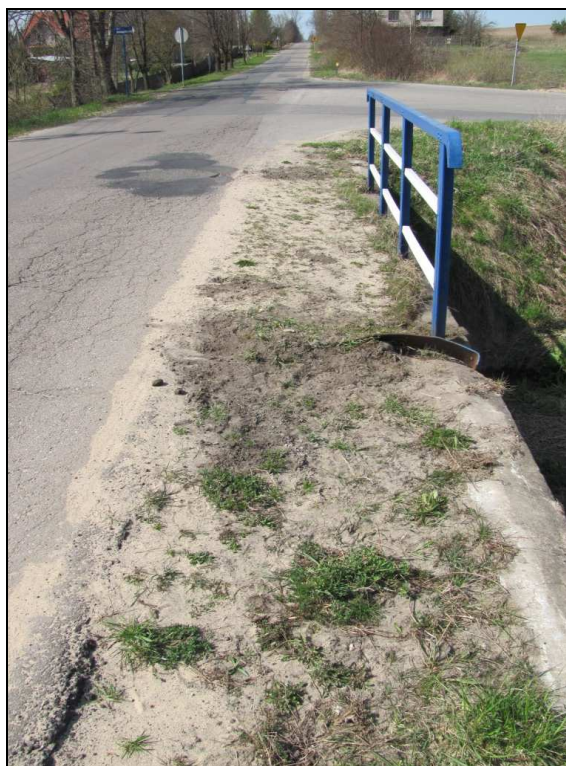
Zdj.8 Pobocze od strony górnej wody - widoczne rozległe zanieczyszczenia i wegetacja roślin, deformacja i korozja blachy osłonowej szczeliny dylatacyjnej.
