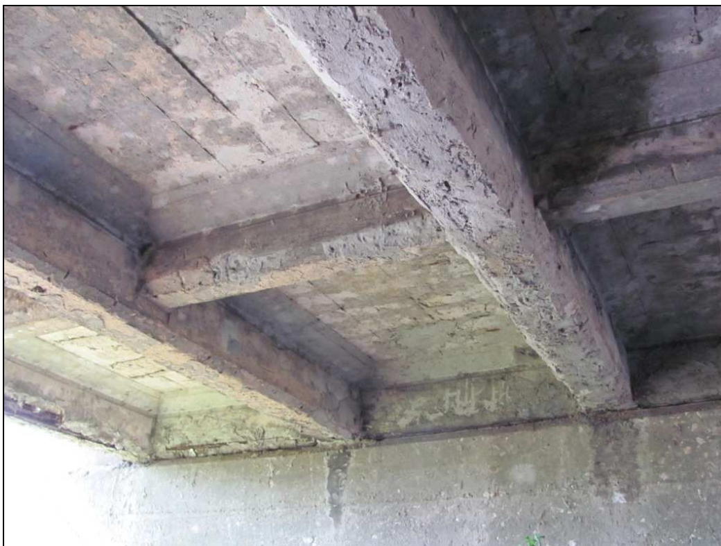
Zdj.13 Konstrukcja nośna - widoczna korozja i ubytki betonu oraz ślady po licznych naprawach betonu.
