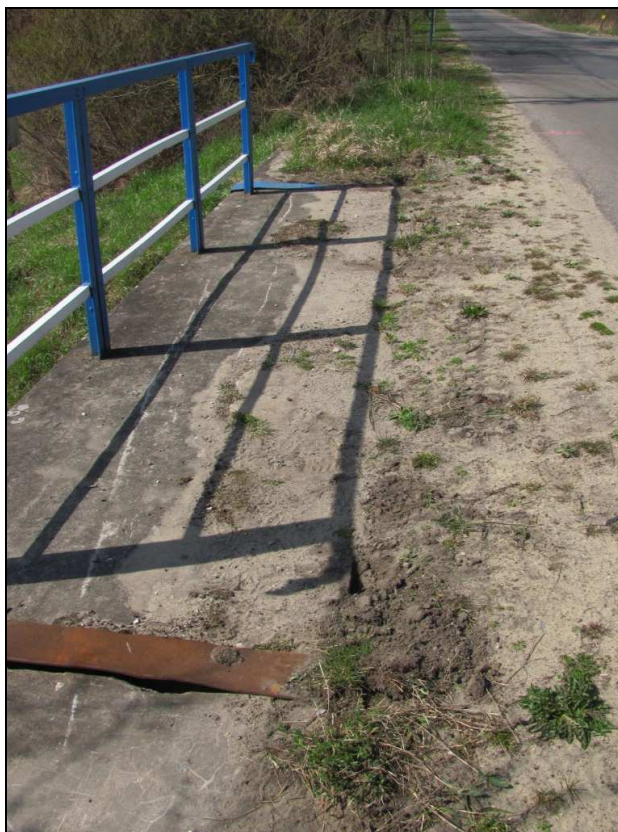
Zdj.9 Pobocze od strony dolnej wody - widoczne zanieczyszczenia oraz korozja i deformacja blachy osłonowej szczeliny dylatacyjnej.
