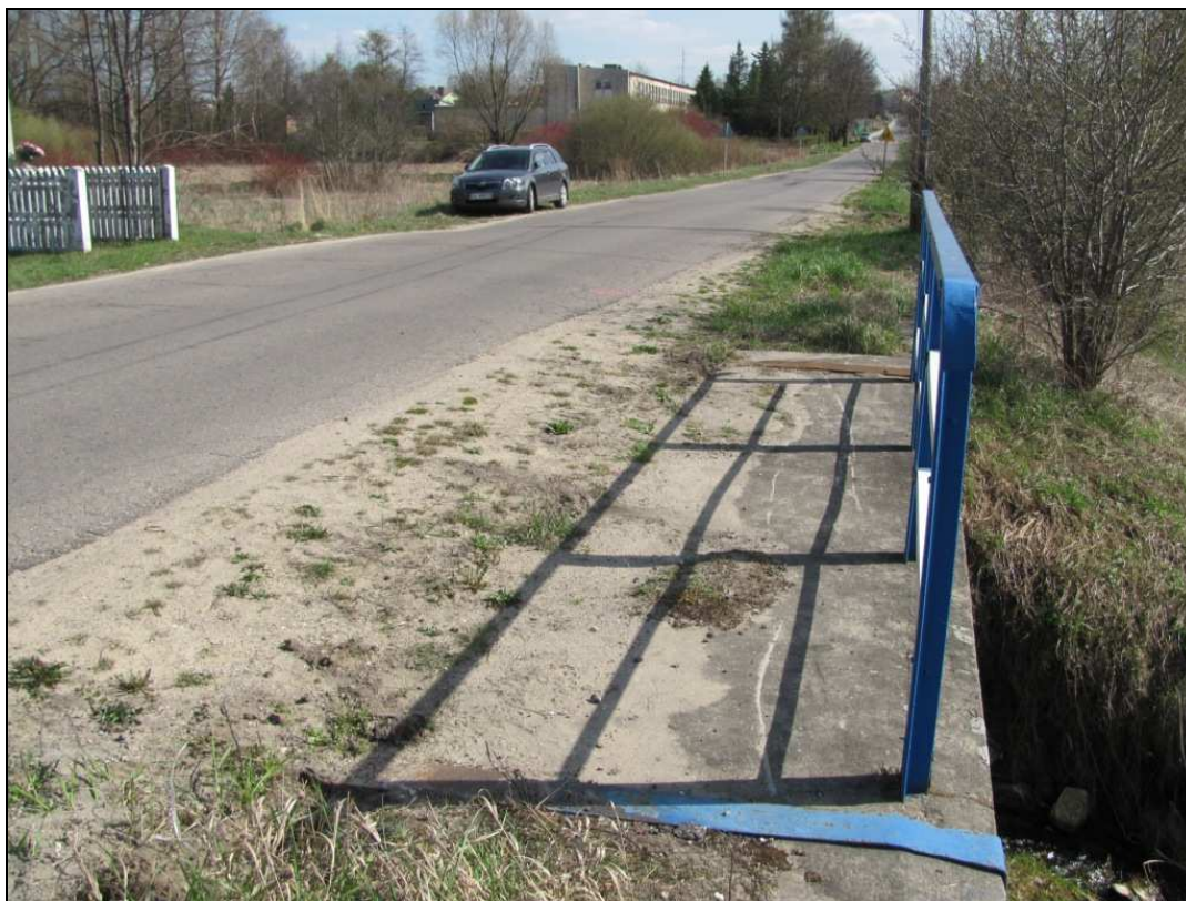
Zdj.7 Nawierzchnia jezdni wraz z poboczem od strony dolnej wody - widoczne zanieczyszczenia pobocza betonowego, spękania.
