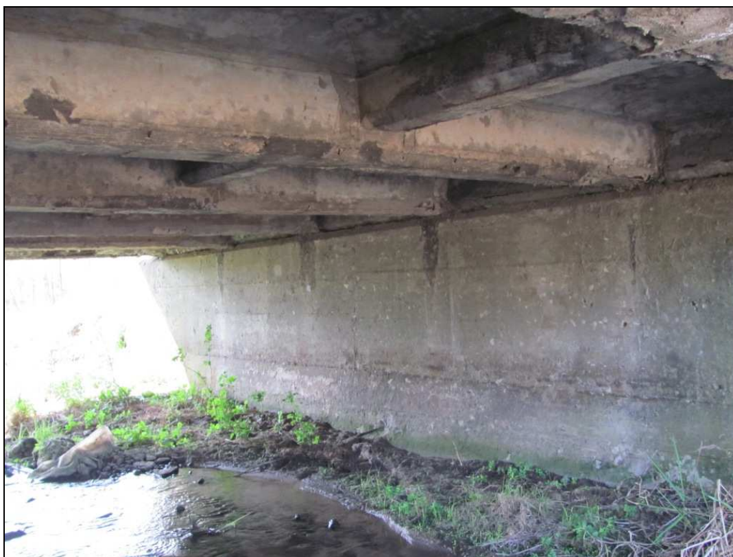
Zdj.22 Przyczółek prawobrzeżny - widoczne osady.
