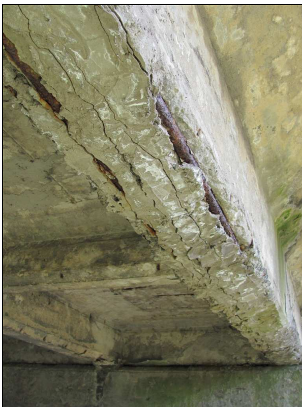
Zdj.16 Konstrukcja nośna - widoczna korozja betonu, spękania betonu dźwigara głównego wzdłuż korodujących prętów zbrojeniowych.
