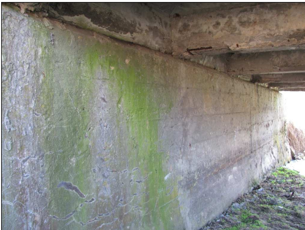
Zdj.21 Przyczółek lewobrzeżny - widoczne białe i zielone osady, wykruszenia betonu.
