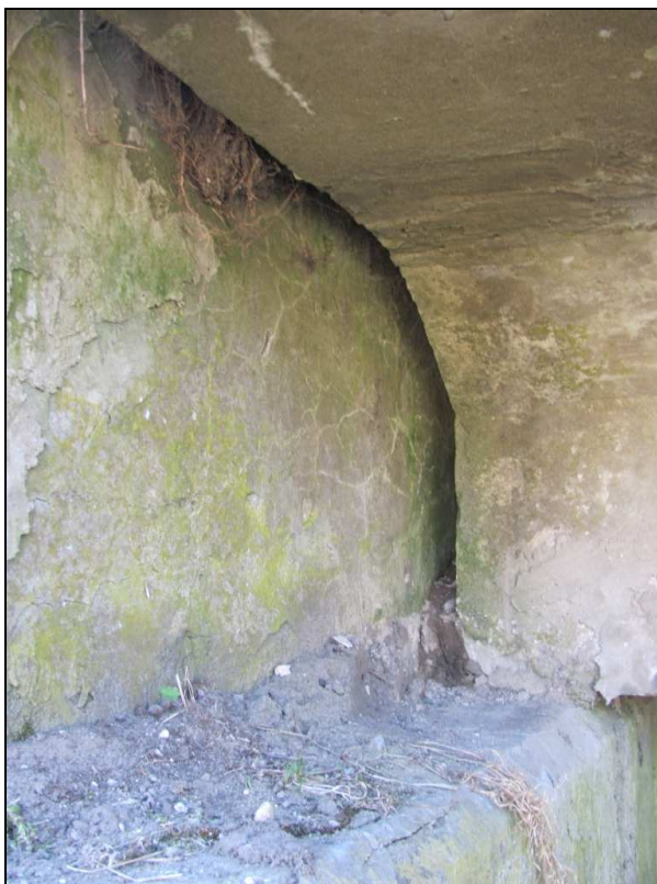
Zdj.19 Przyczółek - widoczne spękania betonu i osady na ścianie zapleczej, zanieczyszczenia i spękania niszy podłożyskowej.
