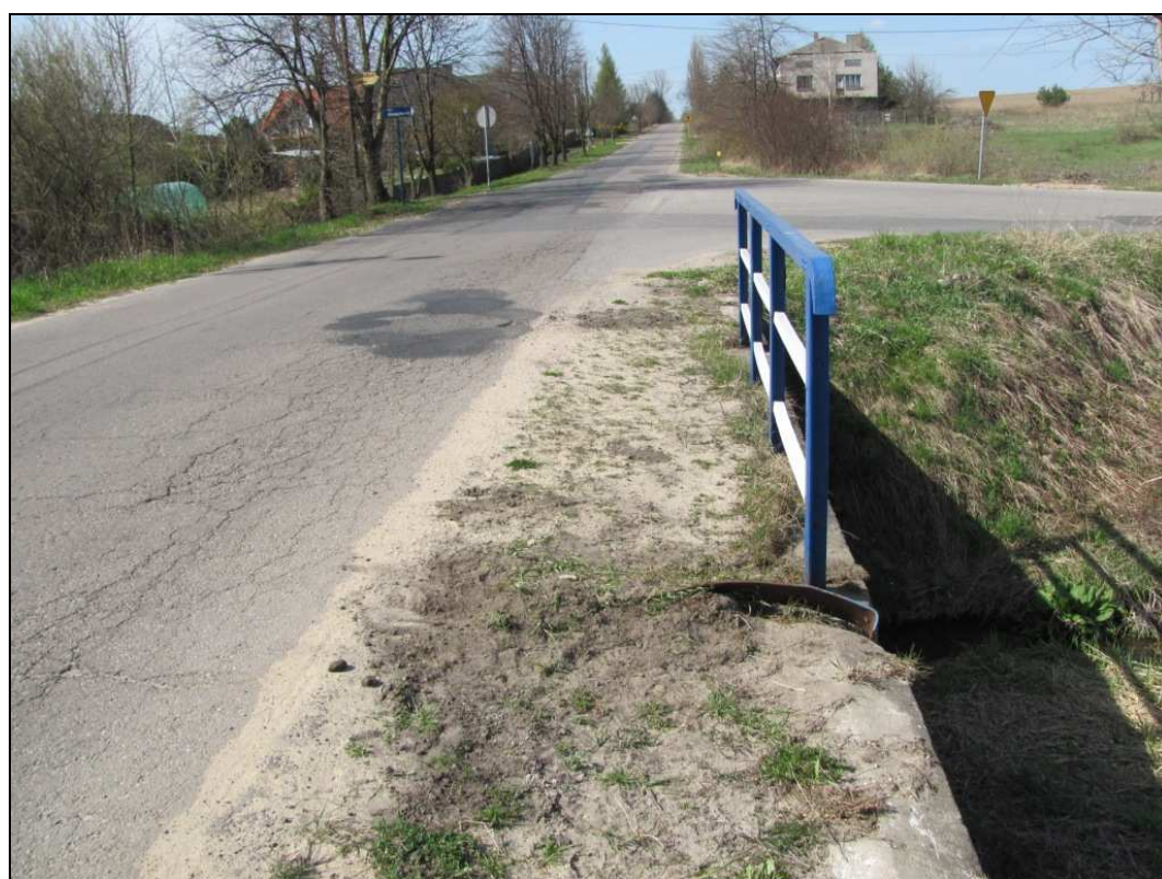
Zdj.6 Nawierzchnia jezdni wraz z poboczem od strony górnej wody - widoczne deformacje i spękania nawierzchni oraz zanieczyszczenia i wegetacja roślin na poboczu. Pęknięcia i ubytki betonu gzymsu pobocza.
