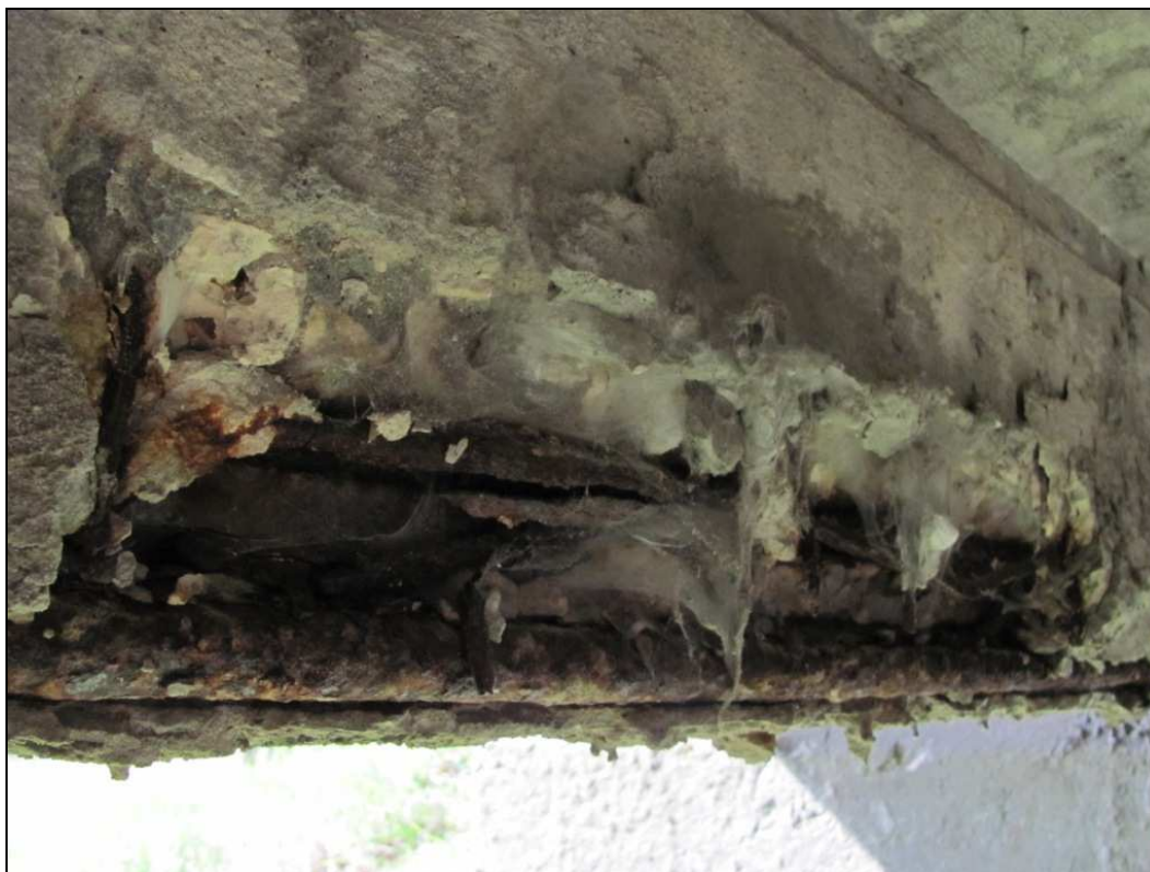
Zdj.15 Konstrukcja nośna - widoczne rozległe ubytki betonu dźwigara głównego, korozja prętów zbrojeniowych.
