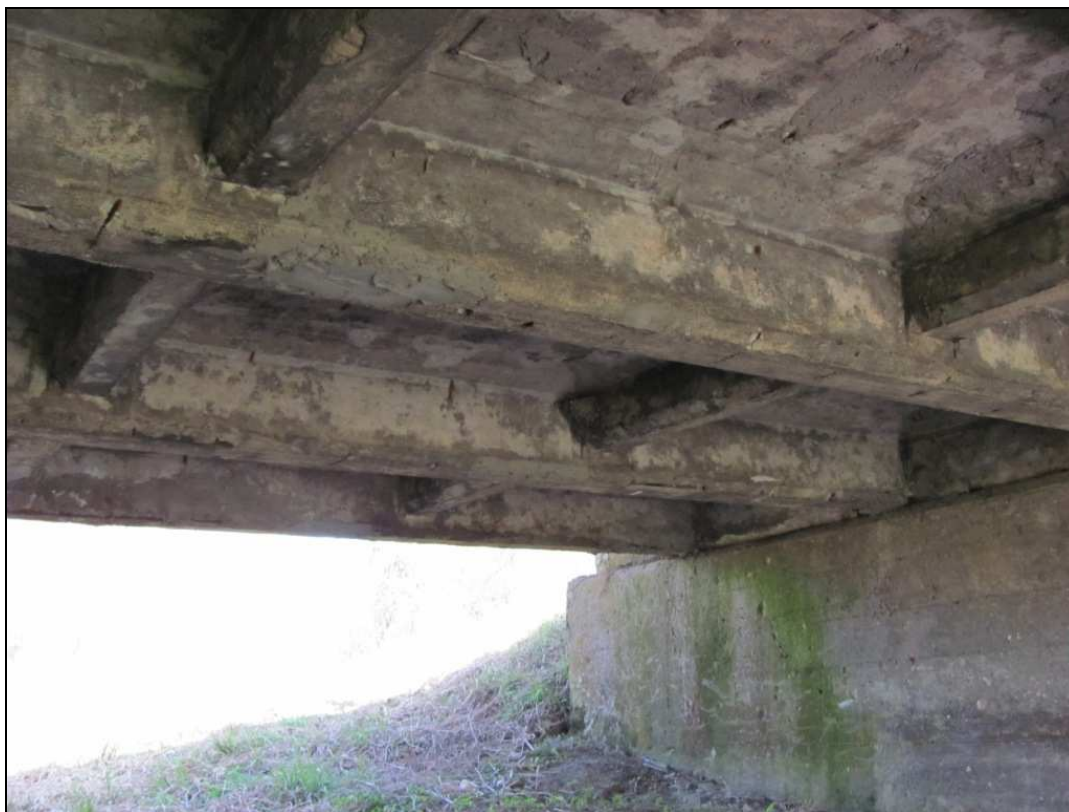
Zdj.17 Konstrukcja nośna - widoczne osady, ubytki betonu, odsłonięte zbrojenie.
