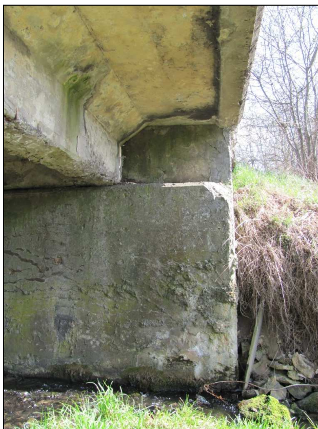
Zdj.18 Konstrukcja nośna z widokiem na przyczółek - przecieki wody i zielone osady na wsporniku podchodnikowym, duże ubytki betonu na narożu przyczółka.
