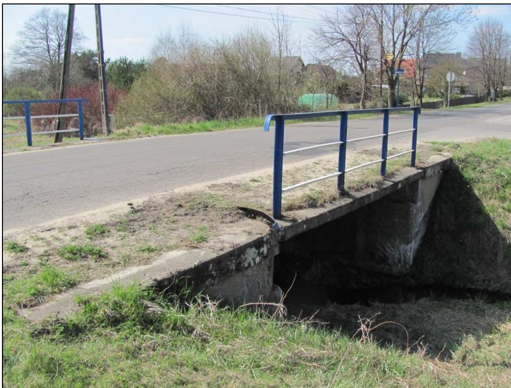
Zdj.11 Gzyms od strony górnej wody - widoczne osady, ubytki betonu.
