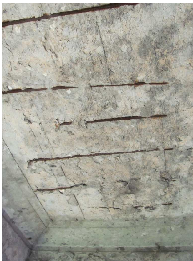
Zdj.14 Konstrukcja nośna - płyta pomostu - widoczny brak otuliny betonowej i korozja odsłoniętego zbrojenia.
