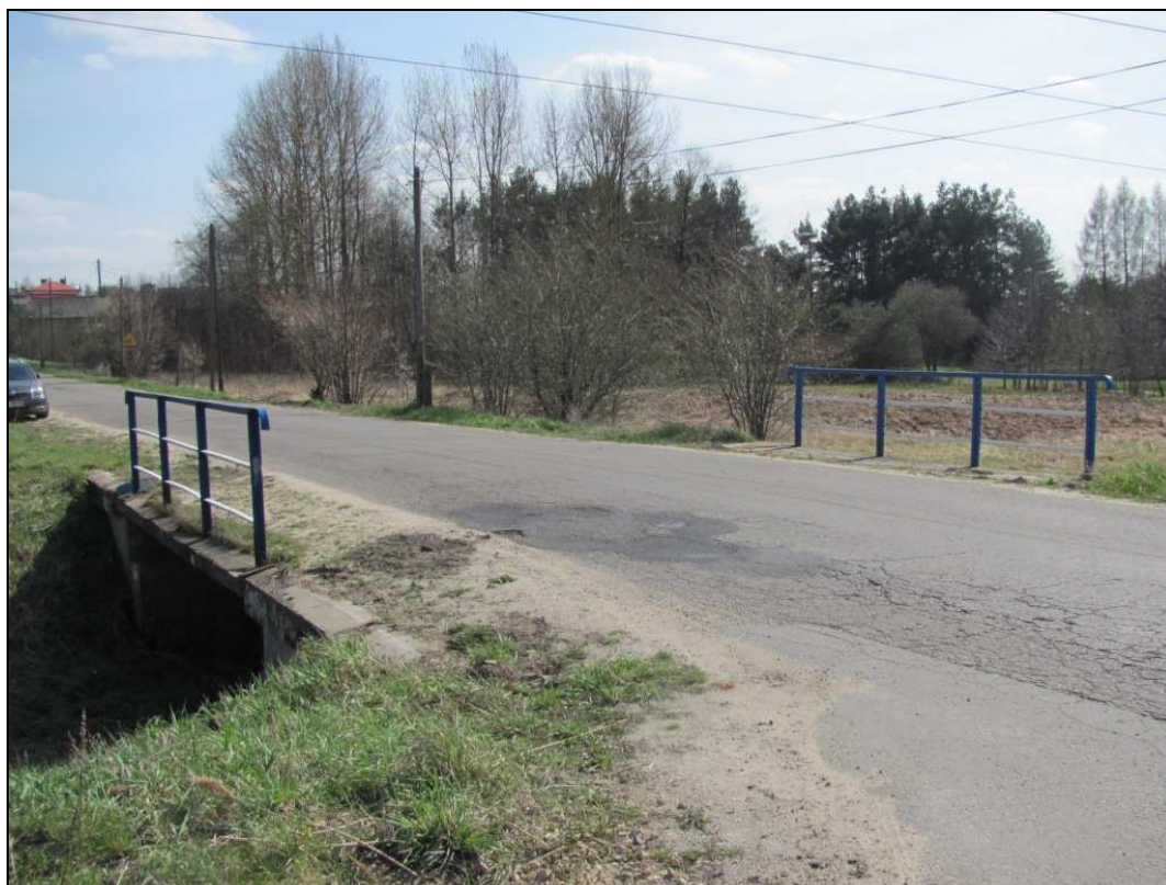
Zdj.5 Nawierzchnia jezdni - widoczne deformacje i siatka spękań.
