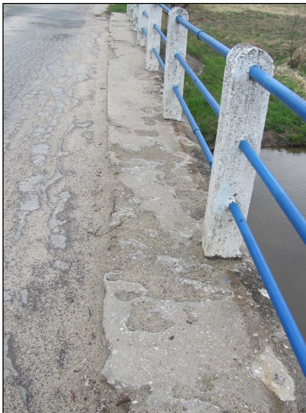
Zdj.8 Pobocze od strony górnej wody - widoczne rozległe ubytki betonu, deformacje, zanieczyszczenia.
