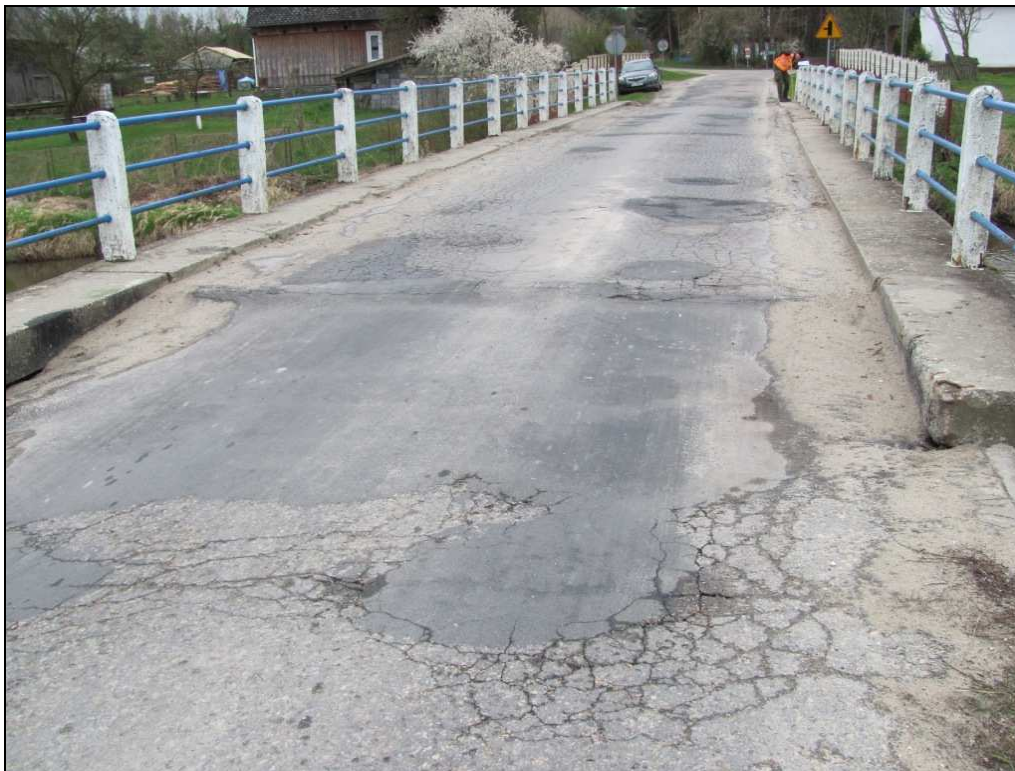
Zdj.7 Nawierzchnia jezdni (wjazd od strony Przyłęku) - widoczne obniżenie progowe na wjeździe na obiekt, deformacje, zapadlistka nawierzchni na krawędzi skrzydeł.
