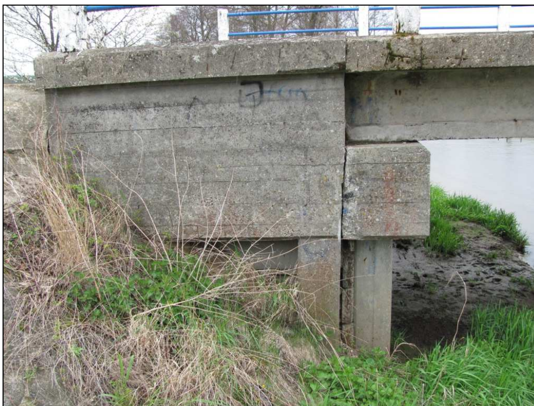
Zdj.22 Przyczółek prawobrzeżny - widoczne zanieczyszczenia (grafitti) oraz ubytki betonu.
