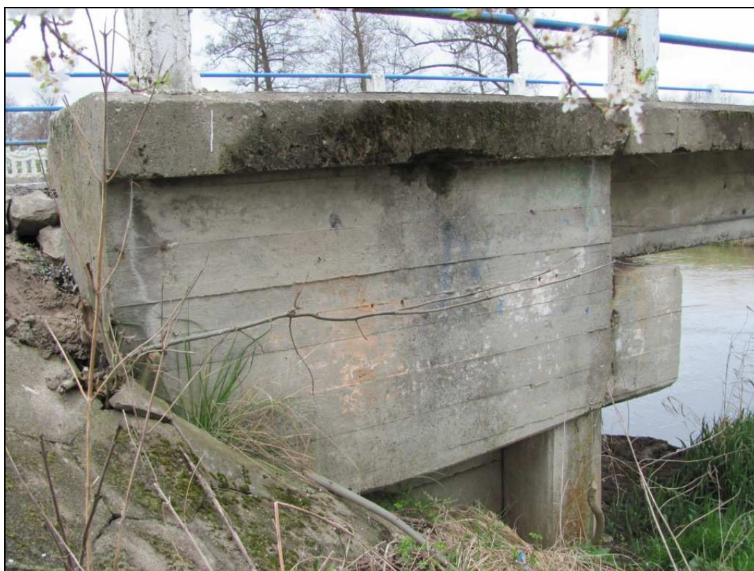
Zdj.26 Przyczółek lewobrzeżny - widoczne osady, odsłonięta końcówka skrzydła.
