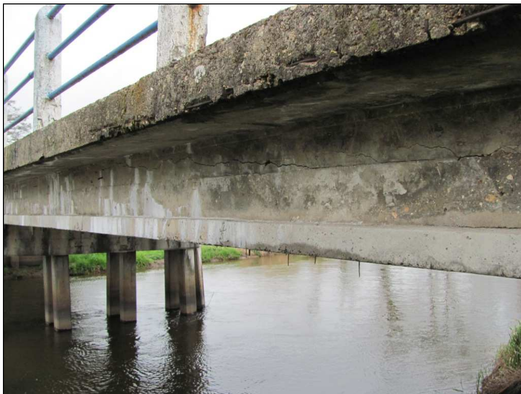
Zdj.11 Gzyms od strony dolnej wody - widoczne ubytki betonu i korozja odsłoniętego zbrojenia oraz osady i wykwity.
