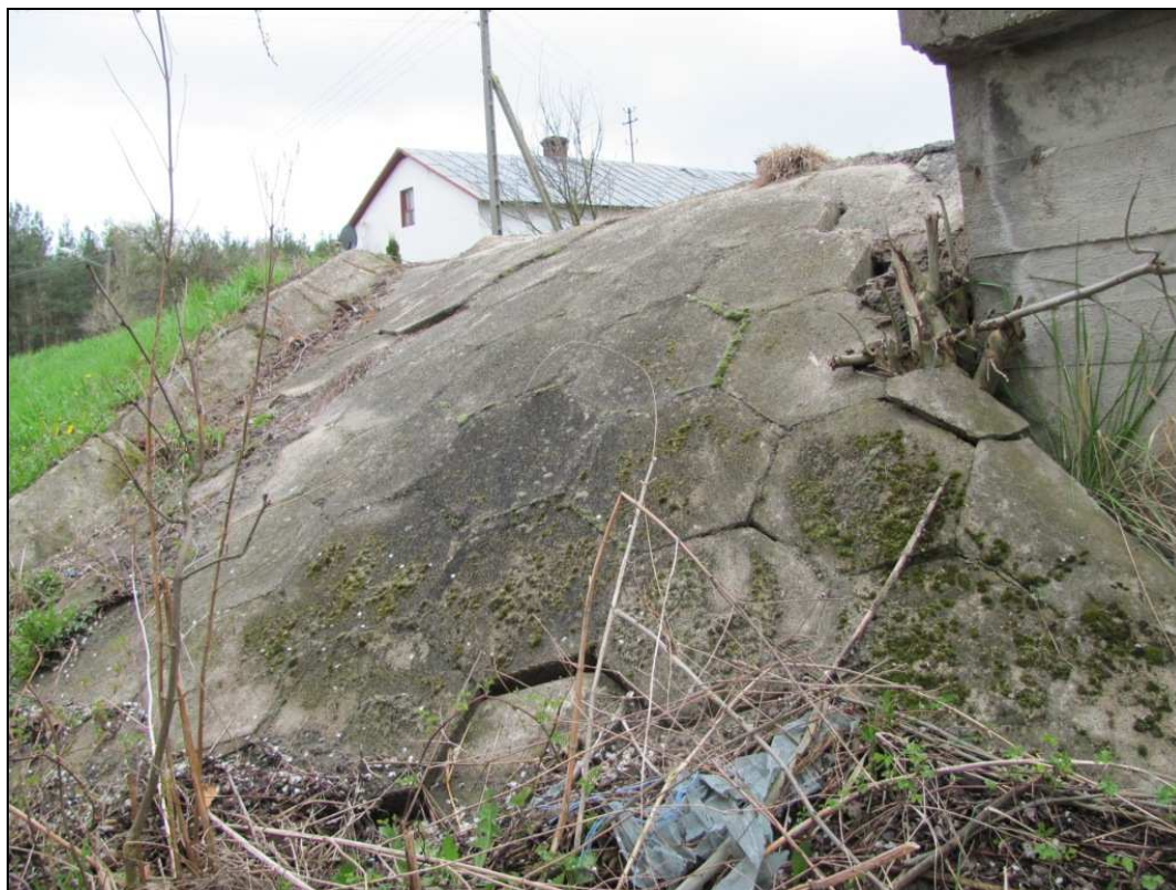
Zdj.27 Umocnienie stożka nasypu - widoczne przemieszczenia elementów, ubytki spoin pomiędzy elementami, wegetacja roślin.
