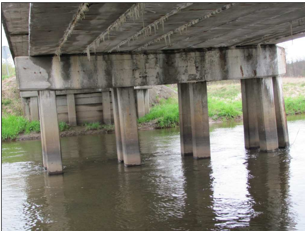
Zdj.20 Podpora pośrednia - widoczne osady i wykwyty na oczepie, osady (związane z poziomem wody w rzece) na filarach.
