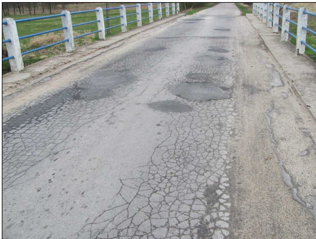
Zdj.6 Nawierzchnia jezdni - widoczne rozległe spękania siatkowe z wykruszeniami, zanieczyszczenia, ślady po licznych naprawach, deformacje.
