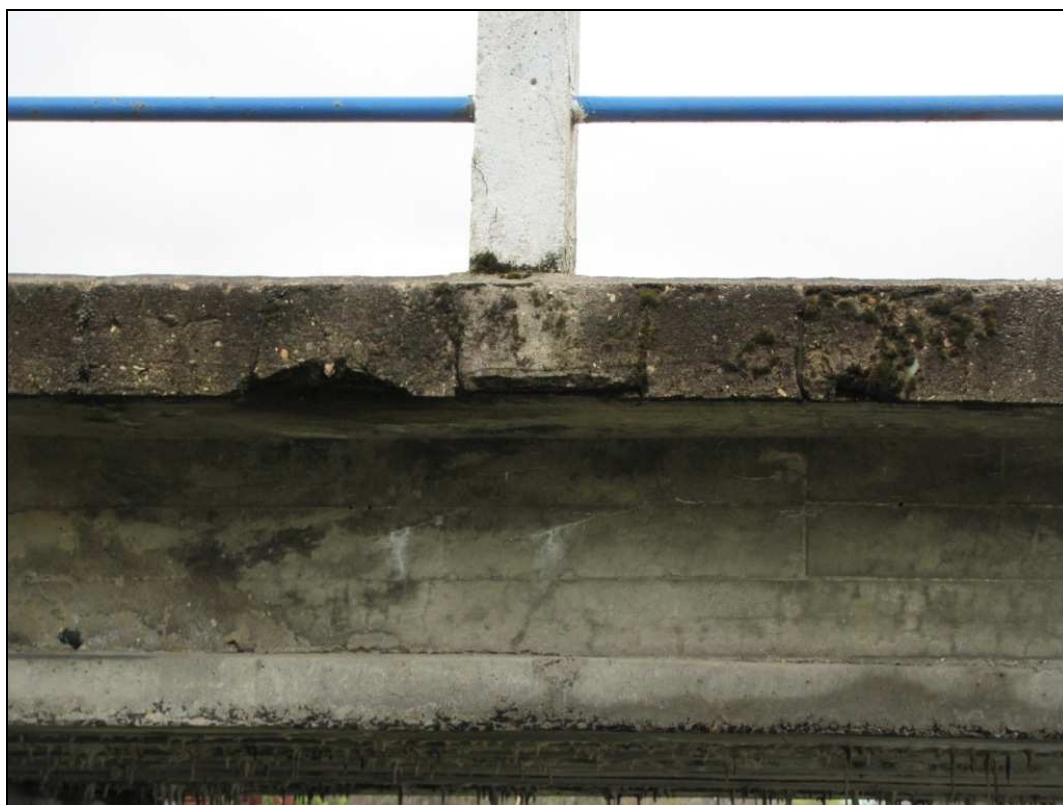
Zdj.12 Gzyms od strony górnej wody - widoczne ubytki betonu i korozja odsłoniętego zbrojenia oraz osady i wykwity.
