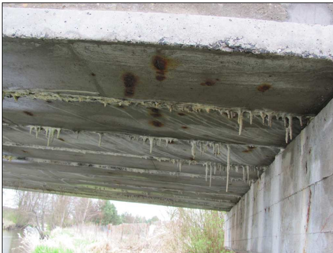
Zdj.14 Konstrukcja nośna - widoczen przecieki, wykwity i stalaktyty pomiędzy belkami prefabrykowanymi.
