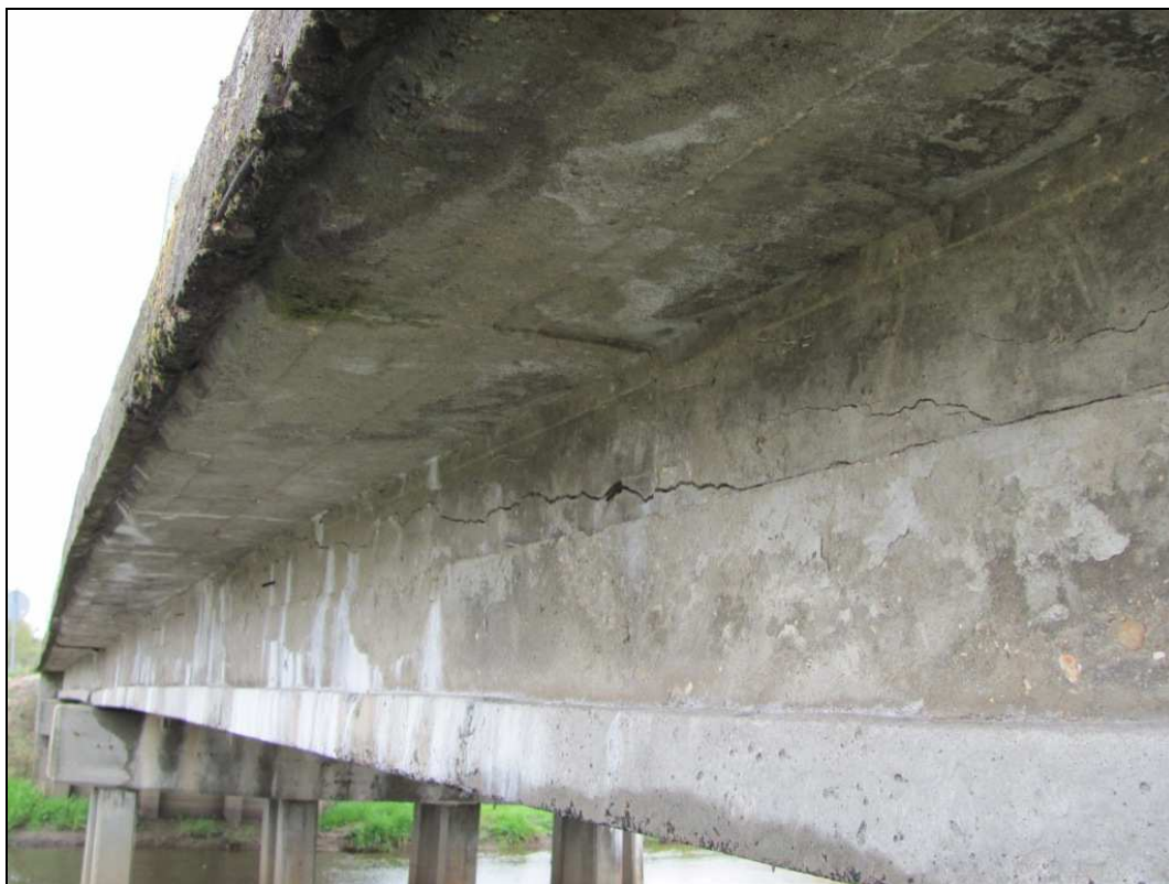
Zdj.15 Konstrukcja nośna - widoczne podłużne pęknięcie na bocznej powierzchni belki oraz osady i wykwyty.
