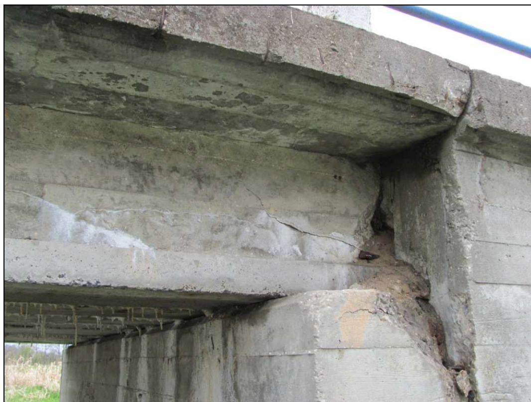
Zdj.16 Konstrukcja nośna - widoczne pęknięcia i ubytki betonu na bocznej powierzchni belki. Widoczne również zanieczyszczenie ławy podłożyskowej i strefy dylatacyjnej.
