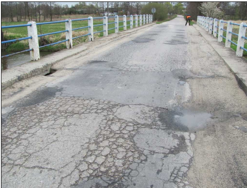
Zdj.5 Nawierzchnia jezdni (wjazd od strony Łąkietyki) - widoczne rozległe spękania siatkowe z wykruszeniami, deformacji i próg na wjeździe na obiekt. Zapadlisko nawierzchni na końcu ustroju nośnego, ponadto zanieczyszczenia.
