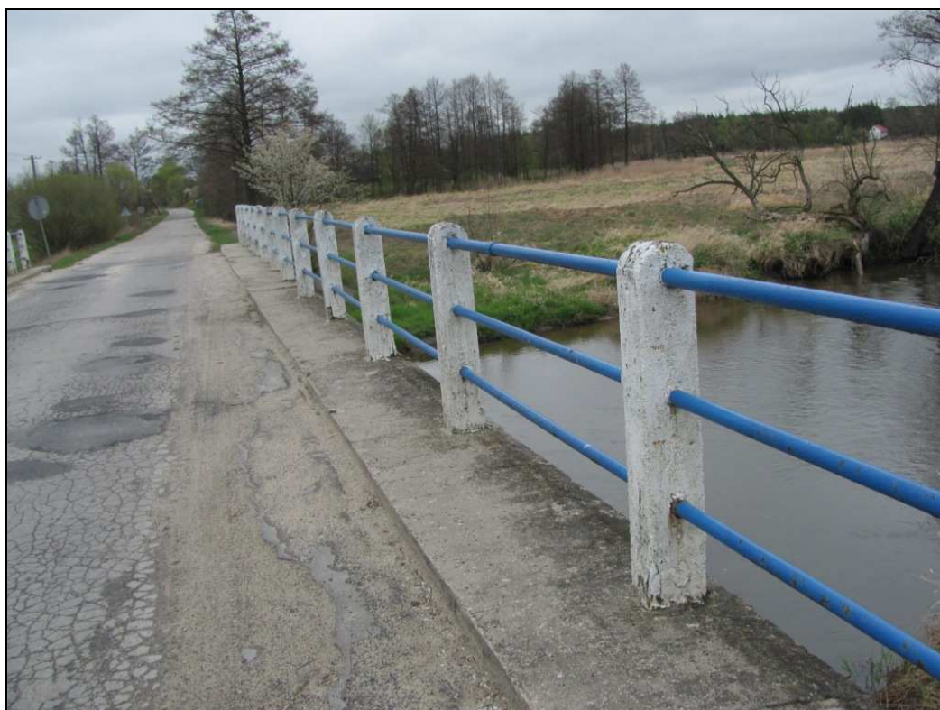
Zdj.10 Balustrada - widoczne ubytki betonu słupków, złuszczenie powłok malarskich i korozja powierzchniowa elementów.
