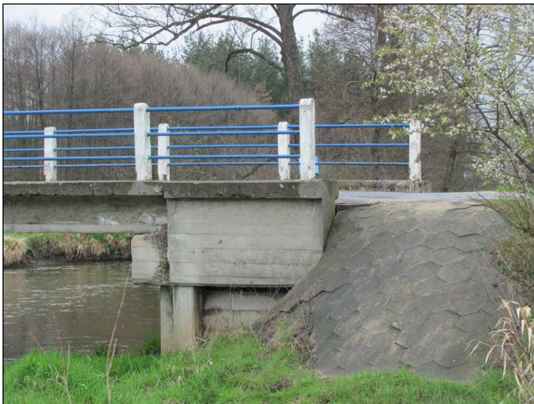
Zdj.23 Przyczółek prawobrzeżny - widoczne ubytki i korozja betonu. Ponadto deformacja umocnień stożka nasypu.
