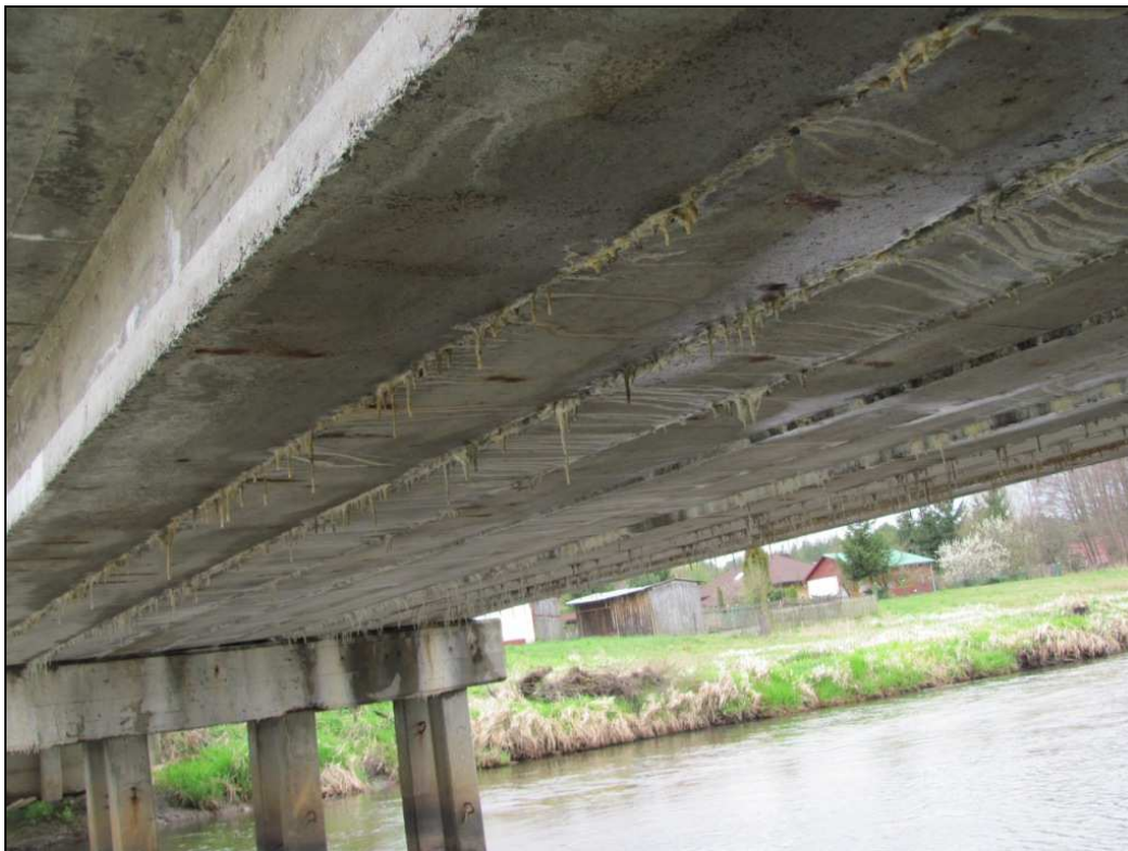
Zdj.17 Konstrukcja nośna - widoczen przecieki, wykwity i stłakatyty pomiędzy belkami prefabrykowanymi.
