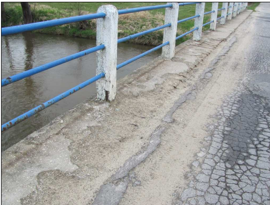
Zdj.9 Pobocze od strony dolnej wody - widoczne rozległe ubytki betonu, korozja odsłoniętego zbrojenia, zanieczyszczenia.
