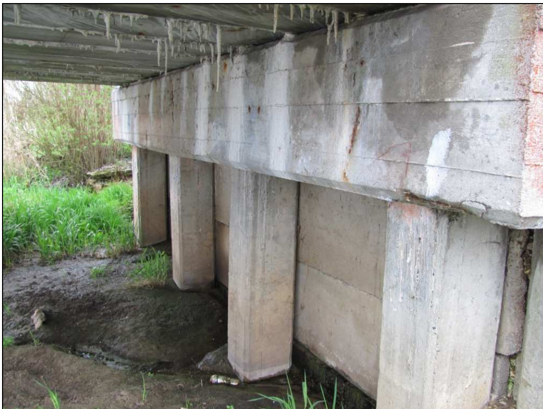
Zdj.24 Przyczółek lewobrzeżny - widoczne osady i wykwyty.
