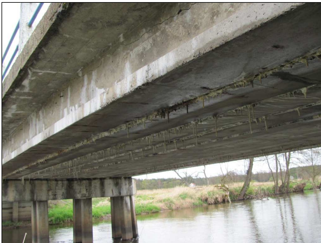
Zdj.13 Konstrukcja nośna - widoczne rozległe przecieki, osady, wykwity i stalaktyty na całej konstrukcji w skutek nieszczelnej izolacji.
