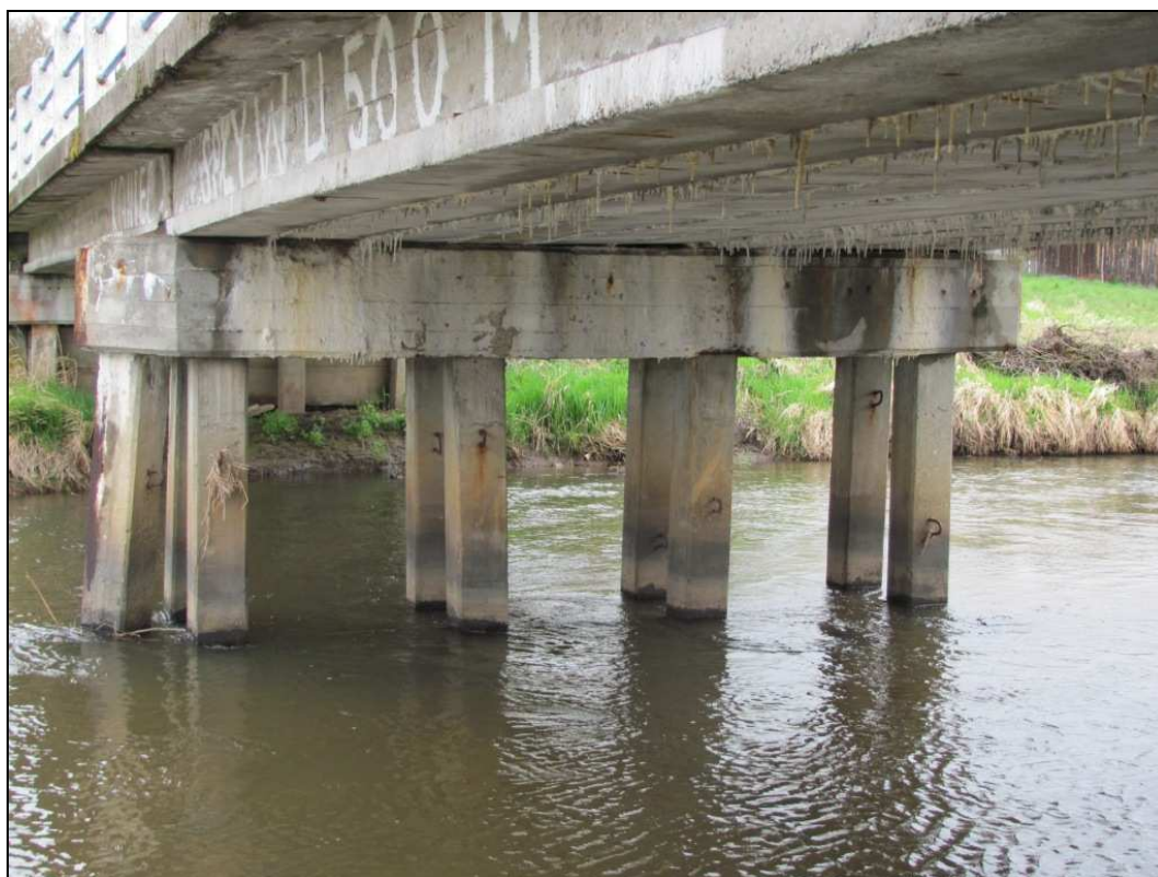
Zdj.18 Podpora pośrednia - widoczne rozległe przecieki, osady i wykwity na oczeple (na skutek przecieków wody przez nieszczelne zabezpieczenie szczeliny dylatacyjnej). Ponadto widoczne osady na filarach (związane z poziomem wody w rzece).
