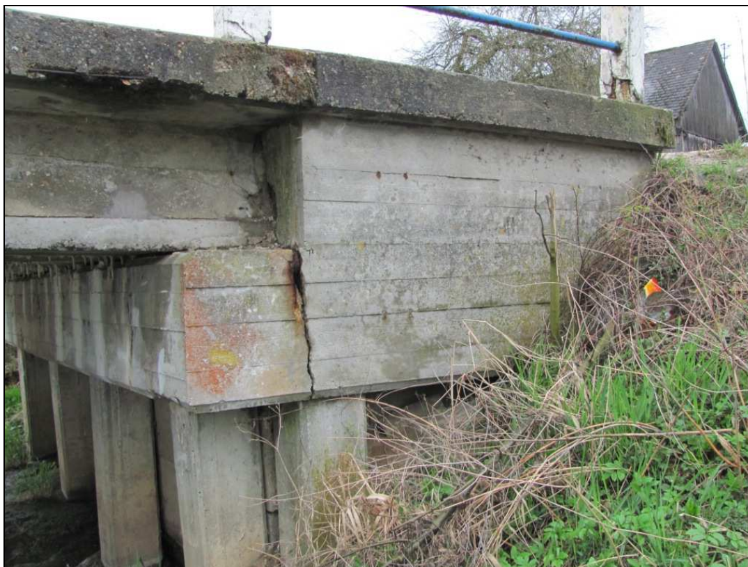
Zdj.25 Przyczółek lewobrzeżny - widoczne osady.
