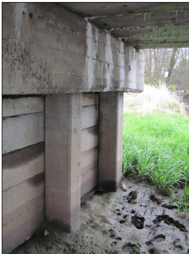
Zdj.21 Przyczółek prawobrzeżny - widoczne osady i wykwyty, zawilgocenia.
