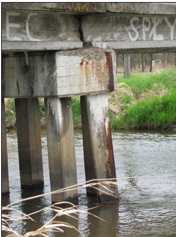
Zdj.19 Podpora pośrednia - widoczna korozja, ubytki betonu oczepu filara, spowodowane systematycznym zalewaniem wodą. Korozja kątownika stalowego.
